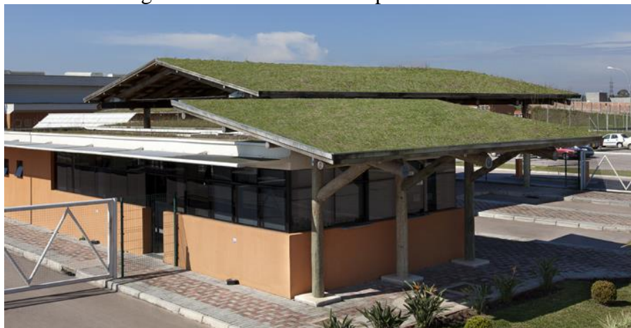
Figura 4. Telhado verde em parte da fábrica.
